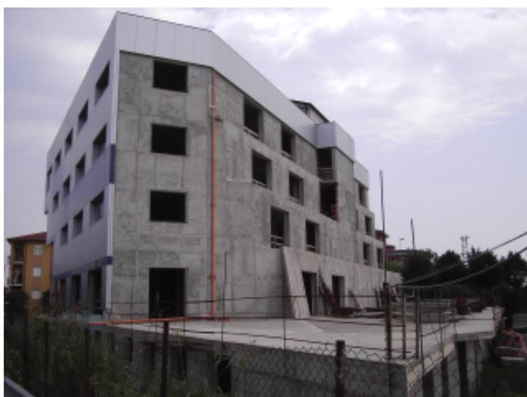
Al momento l'immobile si presenta esternamente con due facciate rivestite da pannelli in alluminio e il rimanente al rustico. I lavori prevedono la sostituzione degli stessi con nuovi serramenti al fine di aumentare la classe energetica dell'edificio. Nonostante il cantiere sia fermo da diversi anni l'edificio si presenta assolutamente sano dal punto di vista strutturale.
